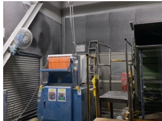
粉碎間鋪設隔音棉降低噪音
