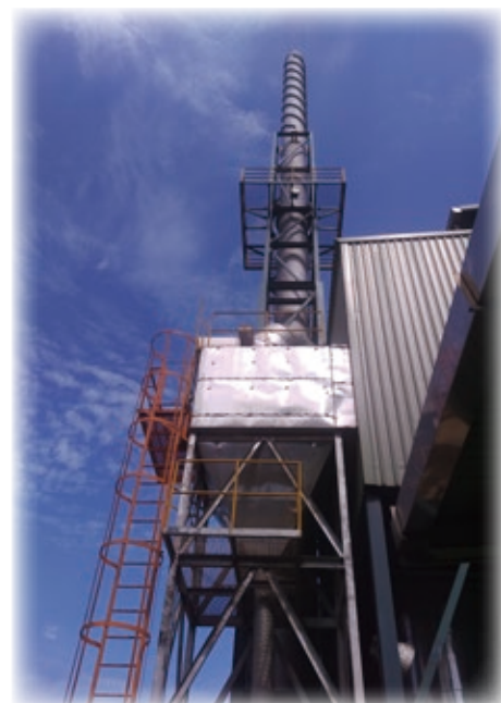
熱媒鍋爐燃油改天然氣
