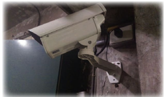
固定污染源攝影機，全天候監控排放狀況
